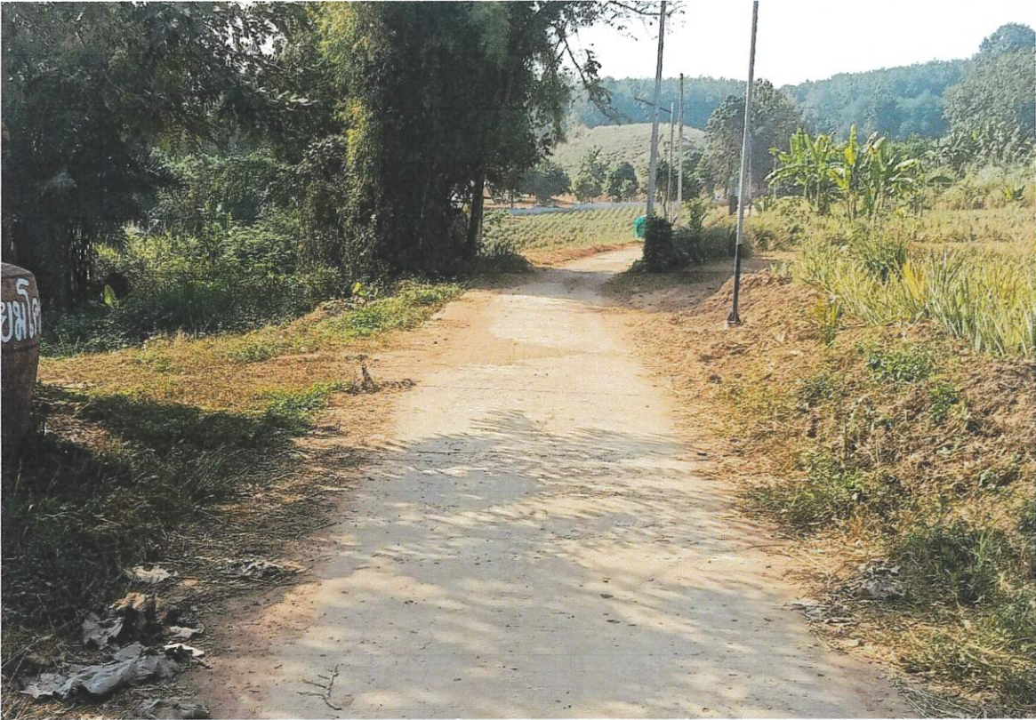
ภาพถ่ายดำเนินการโครงการปรับปรุงผิวถนนแอสฟัลต์คอนกรีต (สายหลัง อบต.น้ำหวาน) สถานที่ บ้านไร่ม่วง หมู่ที่ 1 ตำบลน้ำหวาน อำเภอเมืองเลย จังหวัดเลย
