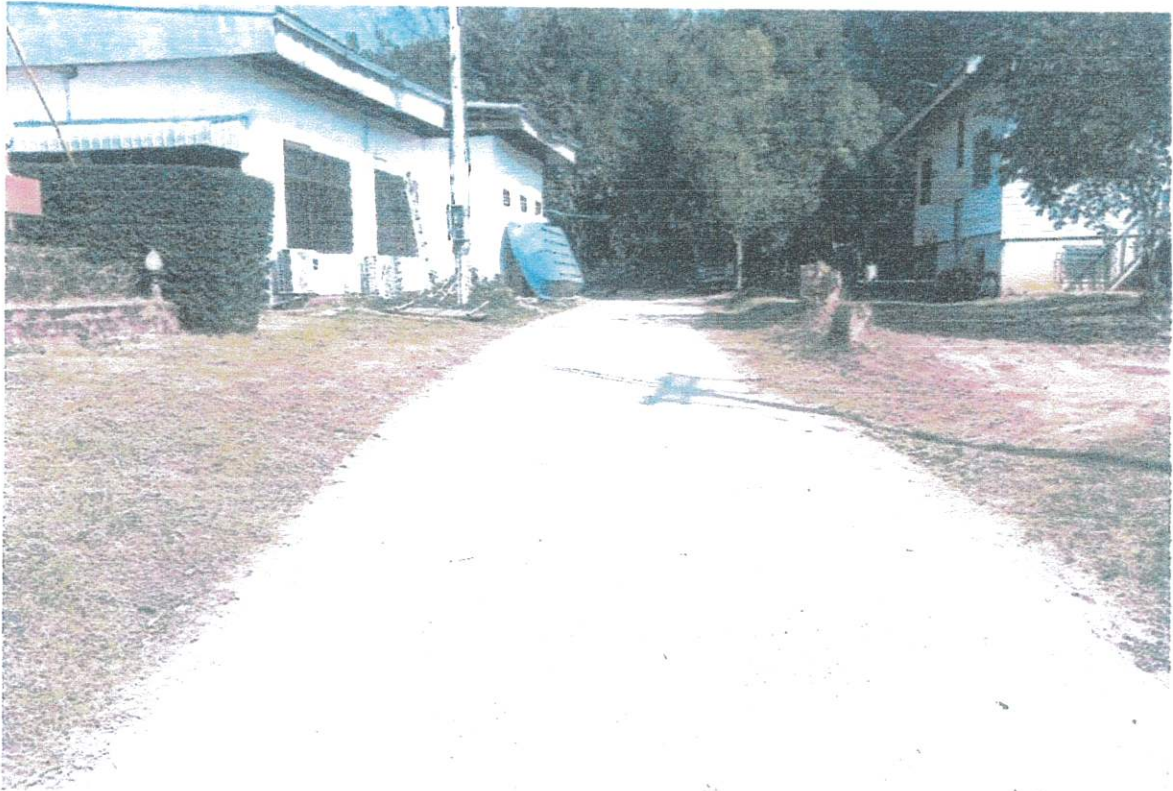
ภาพถ่ายดำเนินการโครงการปรับปรุงผิวถนนแอสฟัลต์คอนกรีต (สายหลัง อบต.น้ำหวาน) สถานที่ บ้านไร่ม่วง หมู่ที่ 1 ตำบลน้ำหวาน อำเภอเมืองเลย จังหวัดเลย
